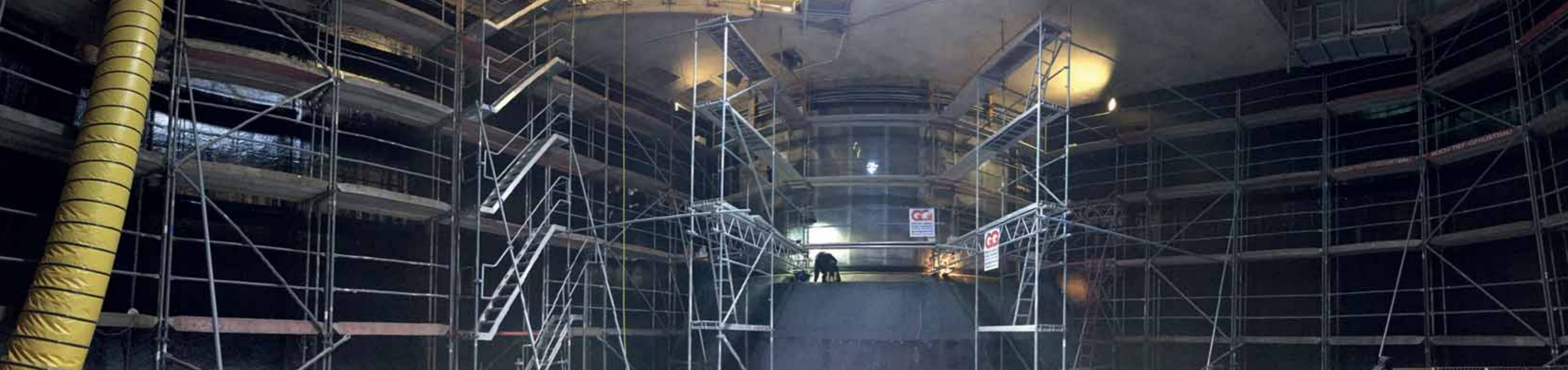
Sanierung des Schwarmfisch-aquariums – Blick aus dem Inneren auf die Panoramascheiben.
