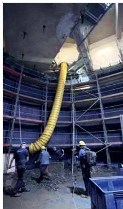
Die Neubeschichtung und Versiegelung der Wände im Großbecken erforderten intensive Entlüftung des Arbeitsbereiches.
