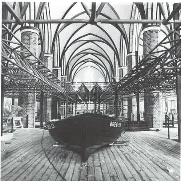
Ohne die historische Bausubstanz zu berühren, wurde ein zweietagiges Stabwerkssystem als Ausstellungsträger in die Halle gestellt.
