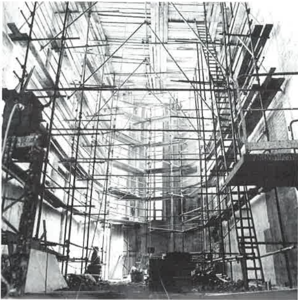
Auch im Chor der ehemaligen Kirche wurden die massiven Zwischendecken entfernt, vermauerte Fenster geöffnet, Gewölberippen gesichert und die erheblichen Bauschäden behoben.
