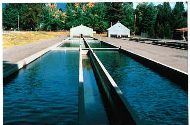
Abb. 2: Beispiel für eine typische Rinnenanlage zur Jungfischzucht.
