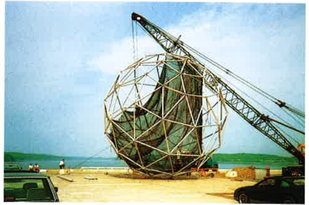
Abb. 5: Installation des Netzes in den neuen kanadischen „Trident“-Käfig vor der Wasserung.
