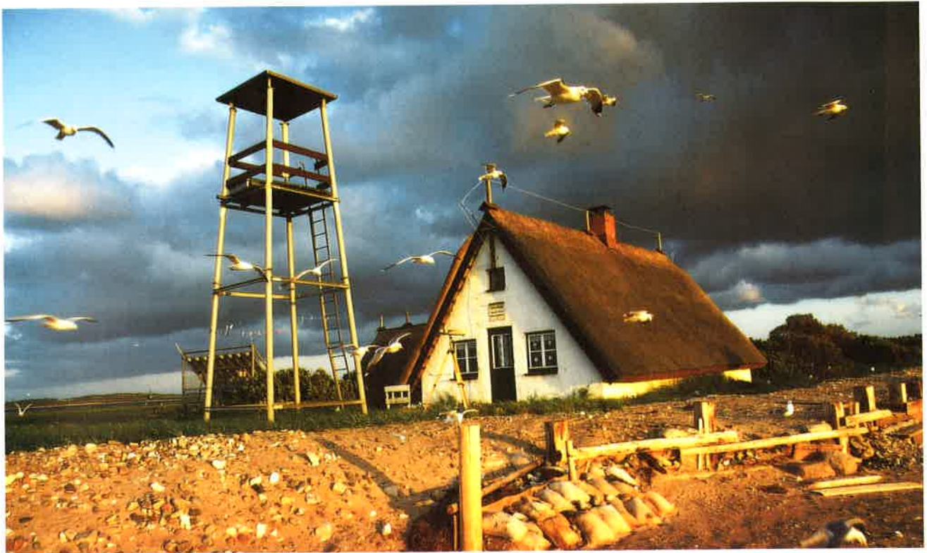
Abb. 1: Das Stationsgebäude mit Beobachtungsturm und Solaranlage.
