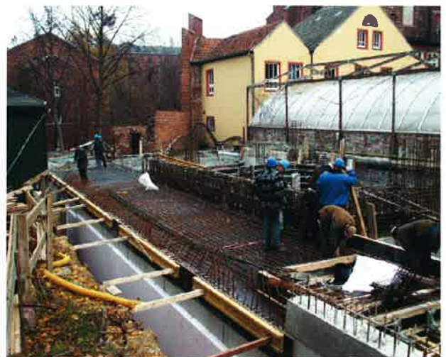
Abb. 9: Baustelle des neuen Meeresschildkrötenbeckens im Deutschen Meeresmuseum.
