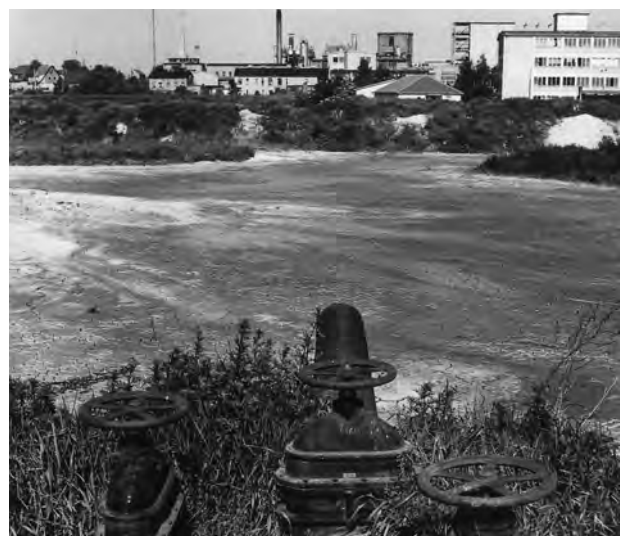
Abb. 3: Die Zuckerfabrik Stralsund 1989 - Blick über die Einlaufrohre auf einen gefluteten „Zuckerteich“.
