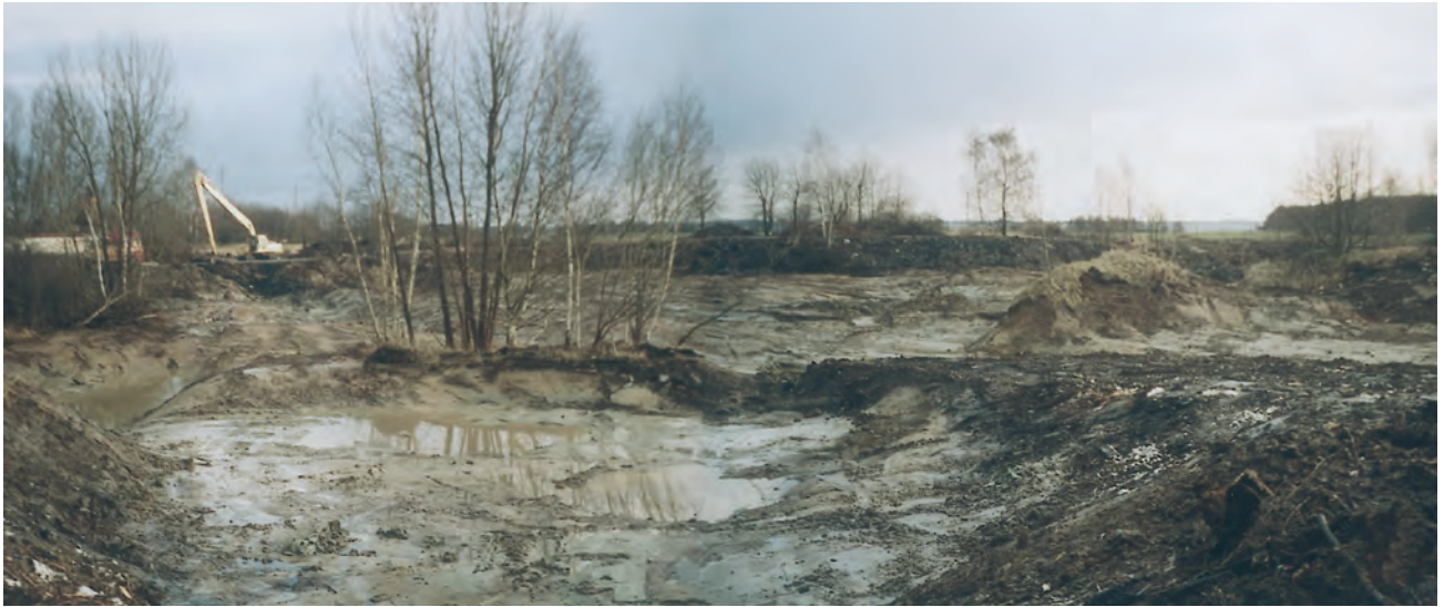
Abb. 25: Beginn der Sanierung im Nov./Dez. 2004. Entnahme der oberflächlichen Öl- und Teerschlämme.
