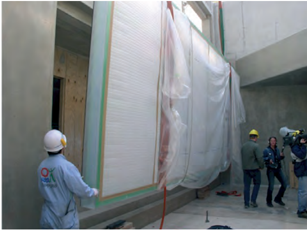
Abb. 12: Die acht mal drei Meter große, 22 Zentimeter dicke und 6,2 Tonnen schwere Acrylglasscheibe für das neue Meeresschildkrötenaquarium wird von Mitarbeitern einer japanischen Herstellerfirma eingesetzt.
