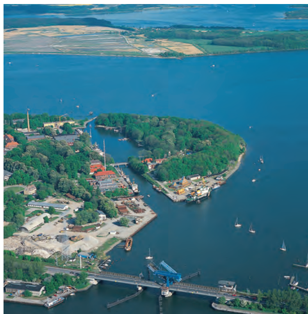
Abb. 2: Der Strelasund östlich von Stralsund. - Unten der Ziegelgraben, der die einzige Insel im Strelasund, den Dänholm (links), vom Festland trennt, mit der Ziegelgrabenbrücke im Zuge der B 96. Auf dem Dänholm rechts das NAUTINEUM Dänholm (Außenstelle des Deutschen Meeresmuseums). Im Hintergrund Halbinsel Drigge, darüber der Mittlere Strelasund mit Halbinsel Devin, Prosnitzer Schanze und Niederhof. Blickrichtung SE.
