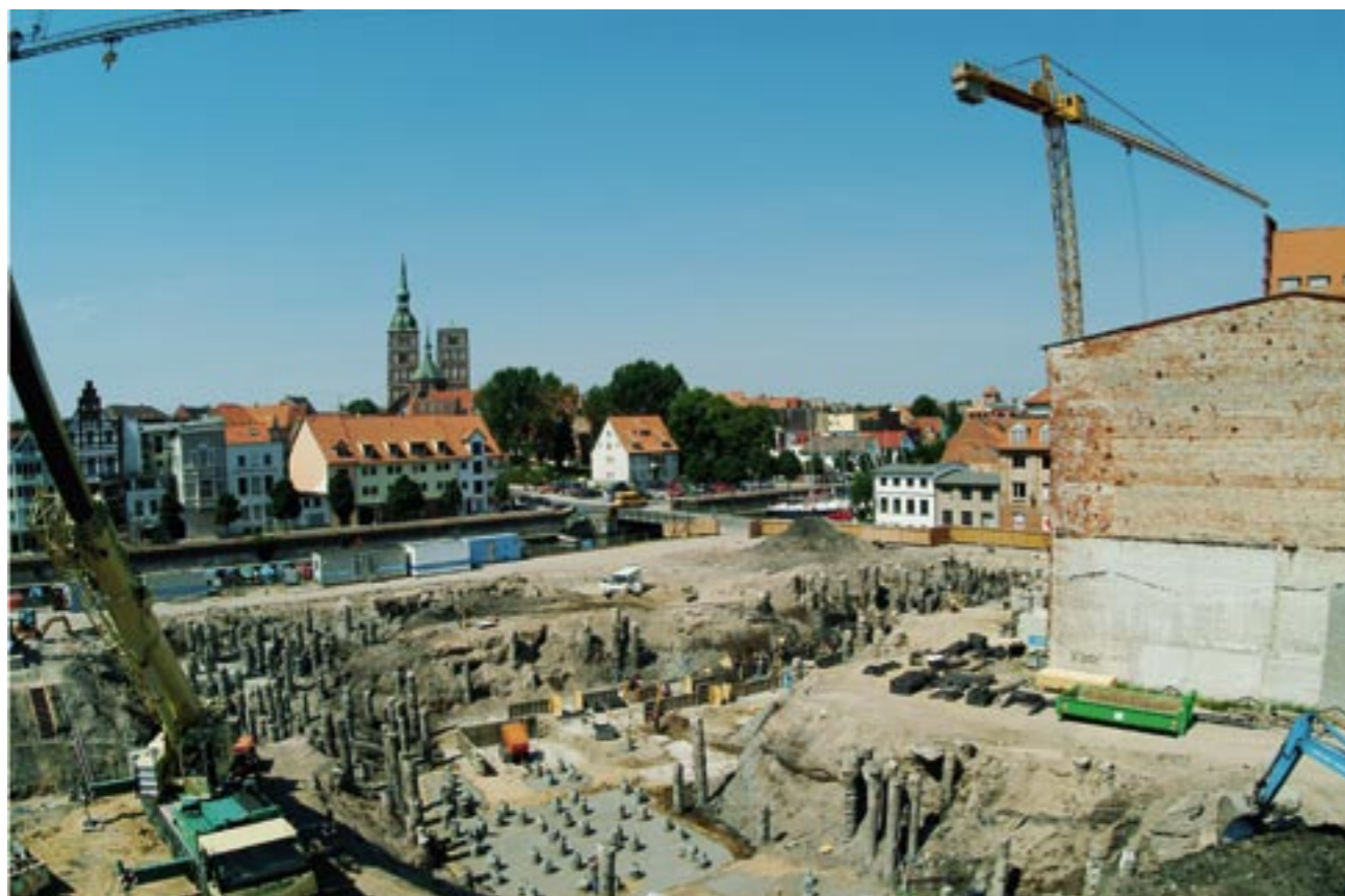
Abb. 18: Im Sommer 2006 waren auf dem Bauplatz lediglich die Gründungspfähle und die ersten Fundamente zu erkennen.
