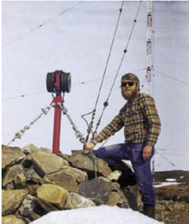
Abb. 12: Die 30 Meter hohe Antenne wurde mit Stahlseilen fest im Felsen verankert.
