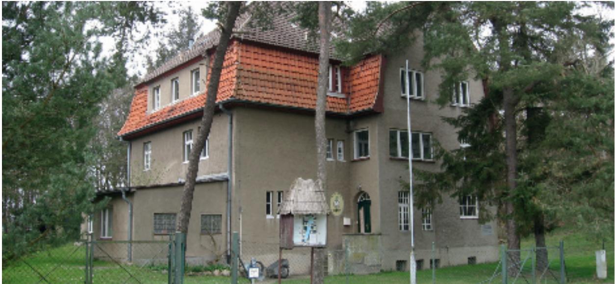
Abb. 13: Das Gebäude der Vogelwarte Hiddensee im April 2007 kurz vor dem Leerzug.
