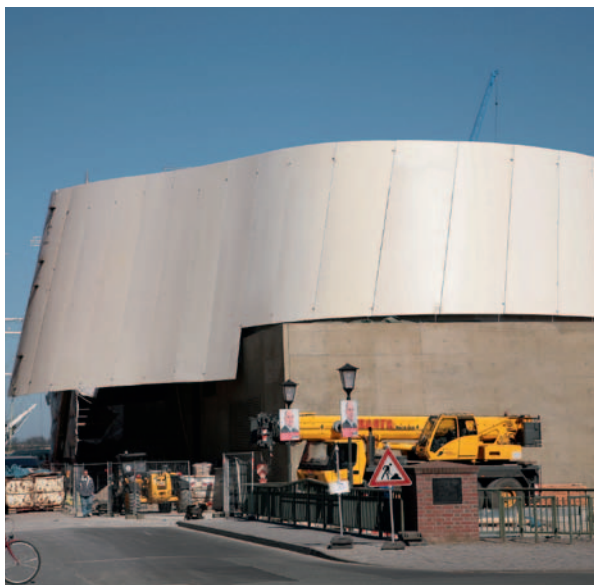
Abb. 22: Nach der Montage der Stahlplattenfassaden nahmen die einzelnen Baukörper ihre endgültige Form an.
