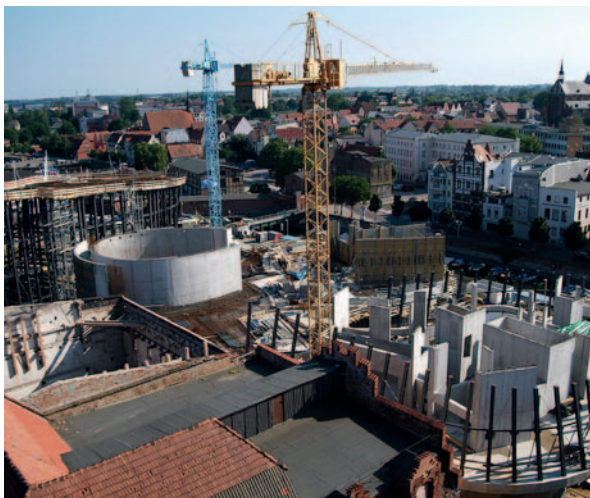
Abb. 14: Unmittelbar nach den Rohbauarbeiten wurden die Betonbecken abgedichtet. Außenwände und Becken der Aquariengeschosse konnten erst nach der Scheibenmontage errichtet werden.
