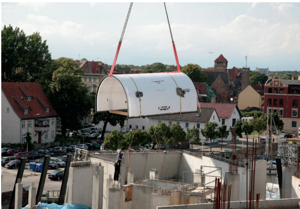
Abb. 16: Der Einbau der Tunnelscheibe erforderte besonders viel Fingerspitzengefühl, weil diese wegen ihrer Form besonders instabil ist, solange sie nicht mit Wasserdruck beaufschlagt ist.
