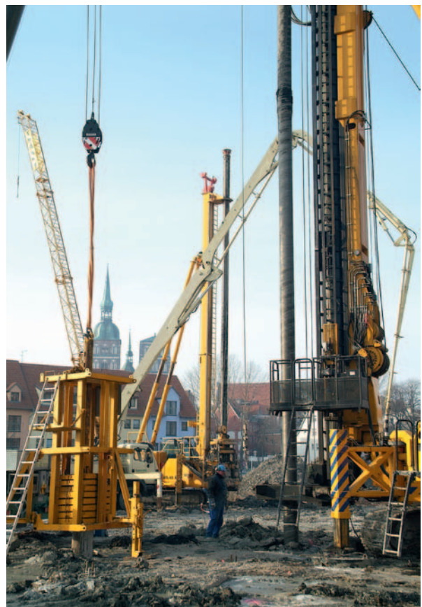
Abb. 1: Mit Großbohrgeräten wurden 691 Gründungspfähle hergestellt.
