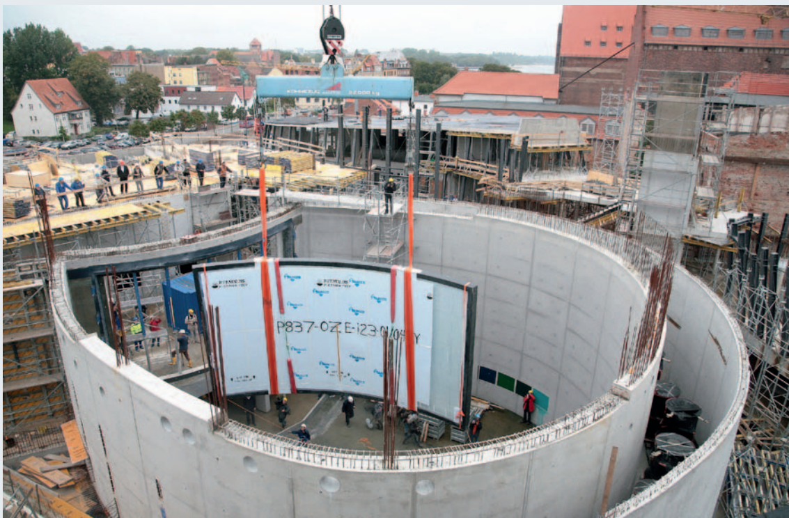
Abb. 17: In der Stunde der Wahrheit musste sich zeigen, ob alle Maße stimmen. Die 22 Tonnen schwere Scheibe wird in Position gebracht.
