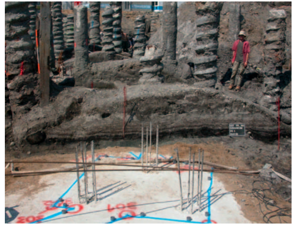
Abb. 13: Juli 2006: Hansestadt Stralsund, OZEANEUM, Torfbrücke. Profil 1, Blick nach Westen; circa 1,50 Meter mächtige Sedimentfolge; unten litorinazeitlicher Basistorf mit Eichenwurzeln und -ästen (circa 7 300 Jahre), darüber Muschelsand mit Pfeffermuscheln, die Ablagerung von Seegrasssand reicht bis ins Mittelalter, ist dann vom anthropogenen Einfluss mit hohem organischen Eintrag überprägt. Die Schichtenfolge wird durch Baggerschlick mit Sandklaffmuscheln abgeschlossen.
