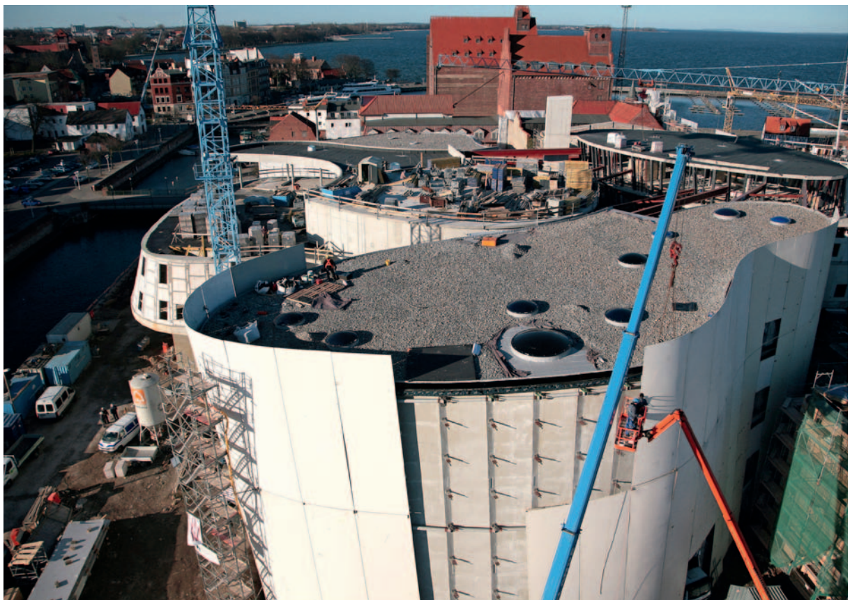
Abb. 25: Die Dächer wurden bis auf die begehbaren Terrassen mit Fasersteinkieseln abgedeckt.
