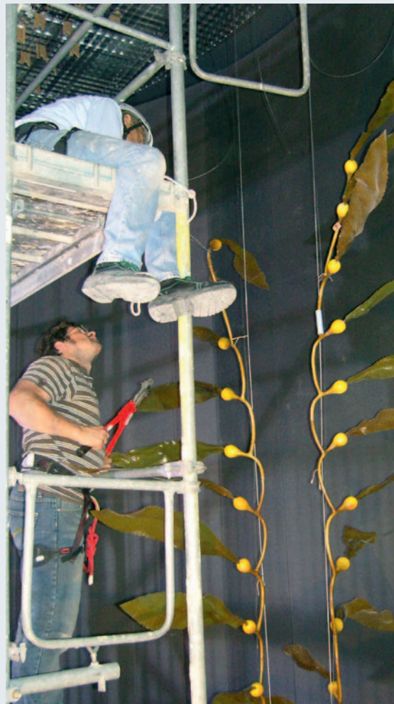
Abb. 3: Montage der vormontierten Riesenkelpsegmente vom Gerüst aus.
