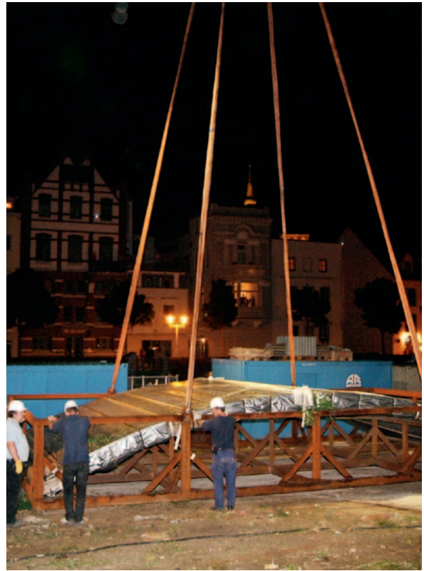
Abb. 15: Die 10 x 5 Meter große Panoramasscheibe ist heil auf der Baustelle eingetroffen.
