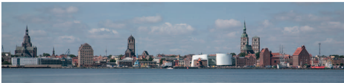
Abb. 5: In der Stralsunder Skyline ist das OZEANEUM schon von weitem zu erkennen. Es fügt sich in die Silhouette der Altstadt ein, ohne diese zu stören.
