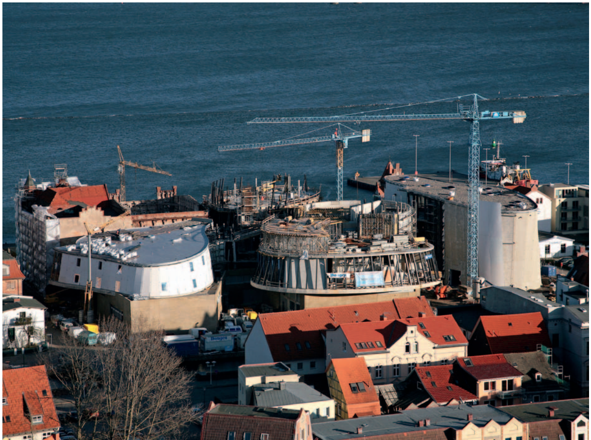
Abb. 19: Ein dreiviertel Jahr vor der geplanten Eröffnung waren die Rohbauarbeiten noch in vollem Gange. Es sind erst vier Musterfassadenplatten montiert.
