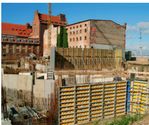
Abb. 5: Die ersten Wände werden geschalt, wie hier für die neun Meter hohen Reservewasserbecken.
