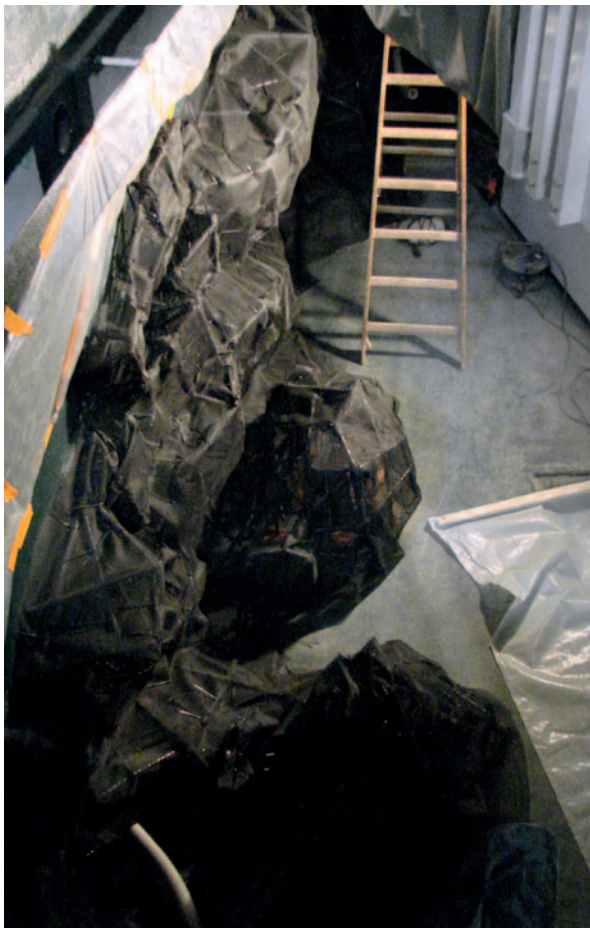
Abb. 5: Verkleidung des Rohrgerüsts mit Trägernetz.
