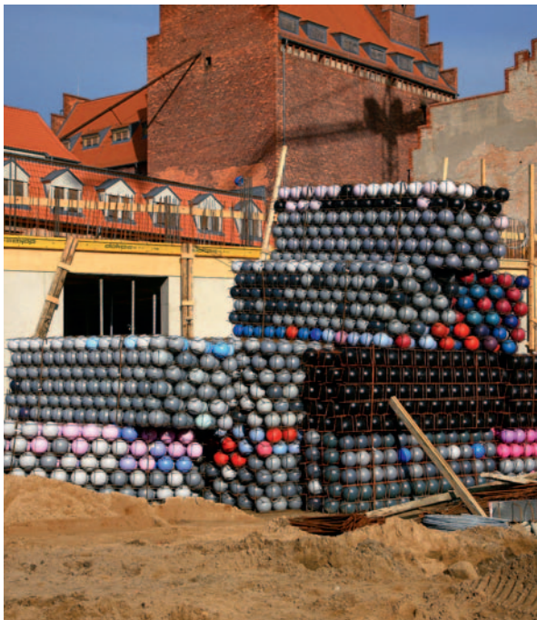
Abb. 7: Mit Cobiakugeln wurden die Betondecken gefüllt, um Eigenlasten zu reduzieren.
