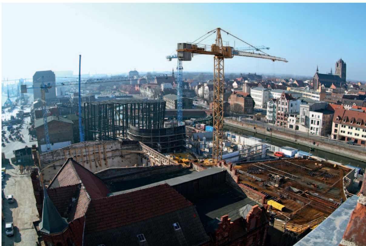
Abb. 11: Während vom Speicher nur die Hülle blieb, wurde der Stahlbau „Riesen der Meere“ fertig gestellt. Unter dem Ostseeaquarium wird eine elf Meter ausragende Decke vorbereitet. Für die Dreharbeiten zum Gustloff-Film wurde ein Teil des Hafens (links oben) in die Zeit des Zweiten Weltkrieges zurück versetzt.
