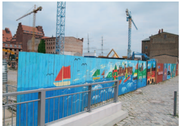
Abb. 2: An dem Malwettbewerb beteiligten sich Künstler und Schüler aus der Region. Innerhalb des Bauzaunes begannen die Bagger tiefe Löcher für die Baugruben auszuheben. Die zuvor betonierten Pfähle mussten bis auf Höhe der Kellersohle wieder abgestemmt werden. Bei dem wunderschönen Wetter war das durchaus eine schweißtreibende Angelegenheit.
