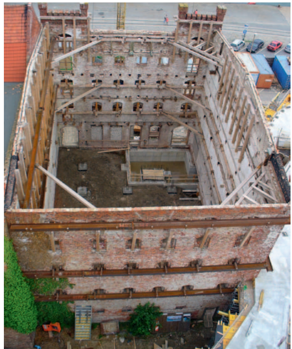
Abb. 10: Von dem ehemaligen Getreidespeicher blieb nur die äußere Erscheinung erhalten. In die alte Hülle wurde ein völlig neues Gebäude eingefügt.
