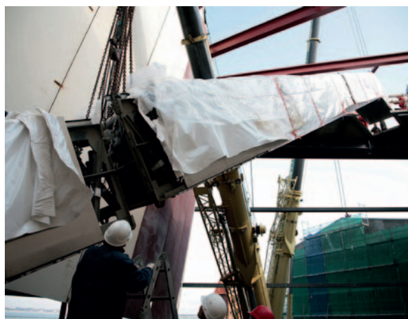
Abb. 23: Unter und zwischen den Dachträgern des Foyers war nicht viel Raum, um die mehr als 30 Meter lange Fahrttreppe an Ort und Stelle zu zirkeln.
