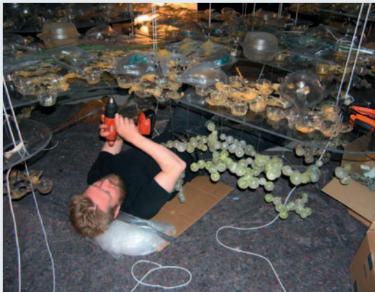
Abb. 10: Die Firma 10 Tons bei der Montage.
