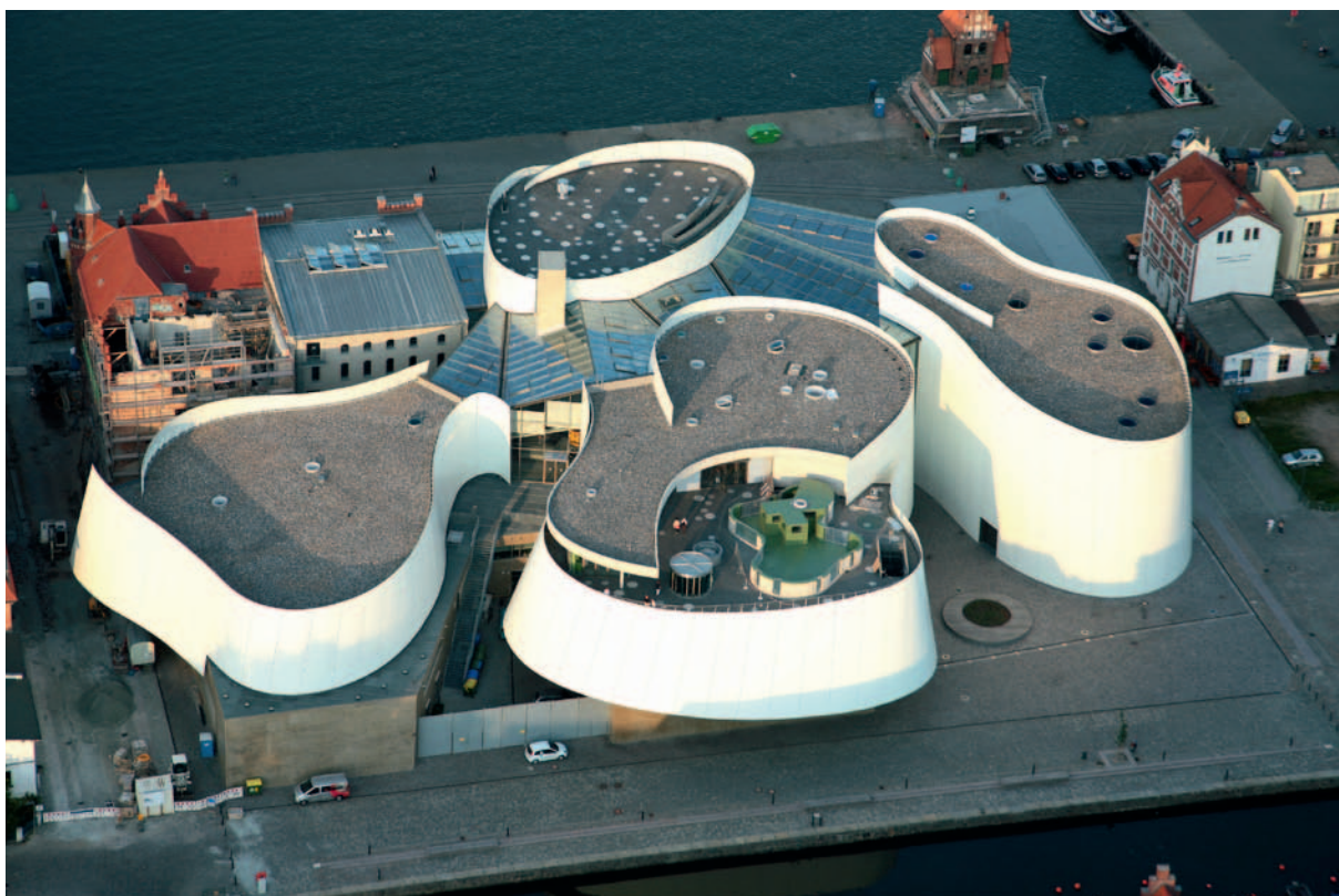
Abb. 4: Das Wettbewerbsergebnis wurde nahezu 1:1 realisiert. Die vier „Bausteine“ werden durch ein lichtdurchflutetes und von Besuchern durchströmtes Foyer miteinander verbunden.
