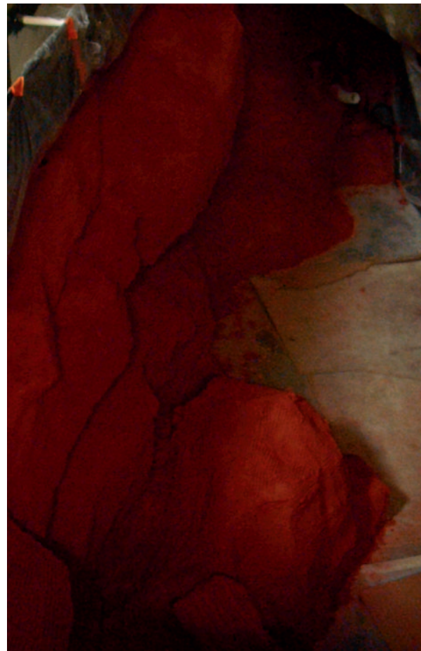
Abb. 6: Farbgebung der Betonbekleidung im Becken „Kattegat“.
