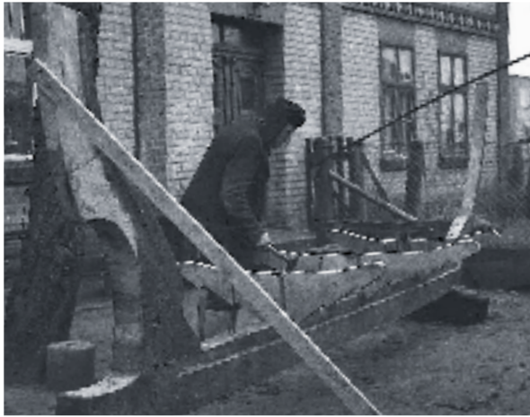
Abb. 17: Bau eines Fischerbootes, das vom Hafen aus operiert (daher der hohe Kiel) in der Werkstatt von F. Hintzke in Chłapowo 1976.
