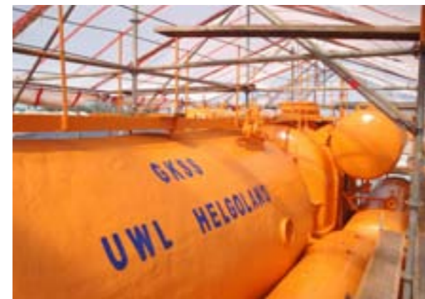
Abb. 18: Nach der kompletten Sanierung erstrahlt das Unterwasserlabor HELGOLAND in neuem Glanz.
