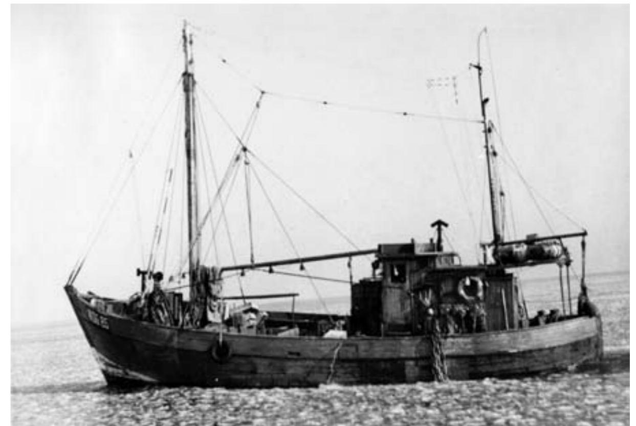
Abb. 6: WOG 85 NEUBRANDENBURG Ende der 1950er Jahre im Eisgang auf der Ostsee. Das Rettungsflöß vom Typ RF 4 DR befindet sich auf der Stellage hinter dem Ruderhaus.
