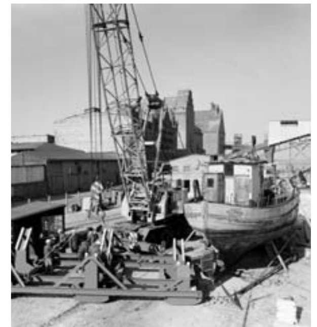
Abb. 16: Der Schlitten auf dem später die ADOLF REICHWEIN ins Meeresmuseum transportiert wurde, wird vorbereitet (1972).
