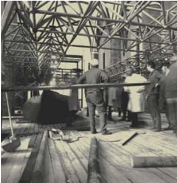
Abb. 6: Das eingebaute Stabwerk in der Katharinenhalle bildete 1974 zwei zusätzliche Geschossebenen. Die ERIKA war das erste Großexponat, das dort aufgestellt wurde.
