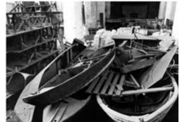
Abb. 9: Keine Sammlung – nur eine Anhäufung von Material, so lagerten die Boote 1986 zwischen Baumaterial in der Jacobikirche.
