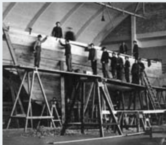
Abb. 8: In Halle III der Boddenwerft werden im Taktverfahren die Schiffskörper gefertigt. Arbeiter montieren das Schanzkleid (1949).
