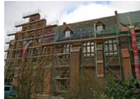
Abb. 37: Durch bewilligte Gelder der SES und wegen des UNESCO-Weltkulturerbe-Status konnte ab Januar 2011 die Dachsanierung des Katharinenklosters begonnen werden.
