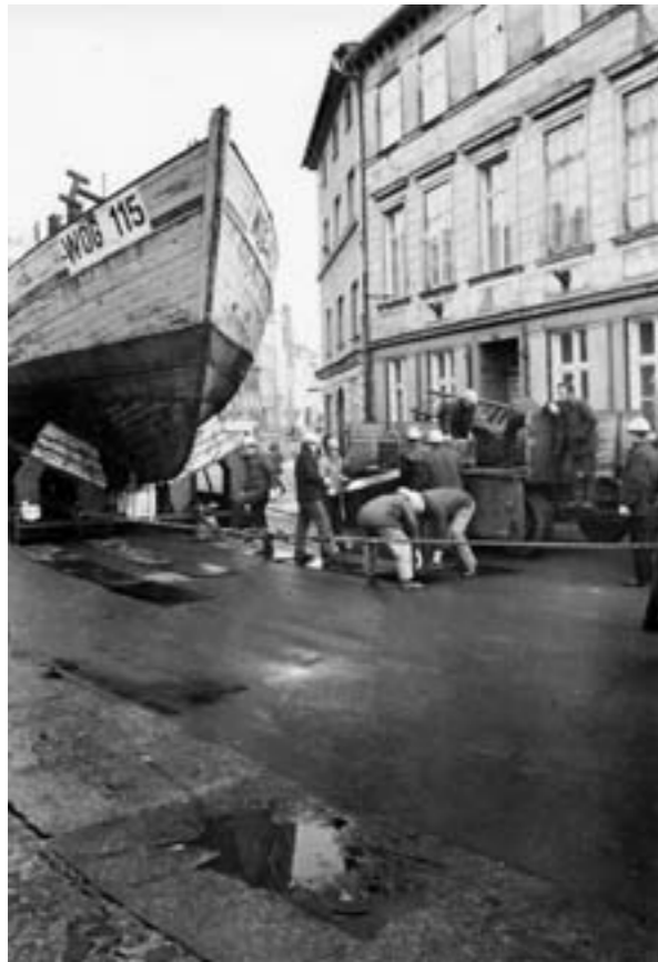
Abb. 18: Wegen der hohen Reibungswiderstände auf dem Asphalt müssen Gleitbleche, bestrichen mit Schmierseife, vor den Kufen des Schlittens ausgelegt werden.
