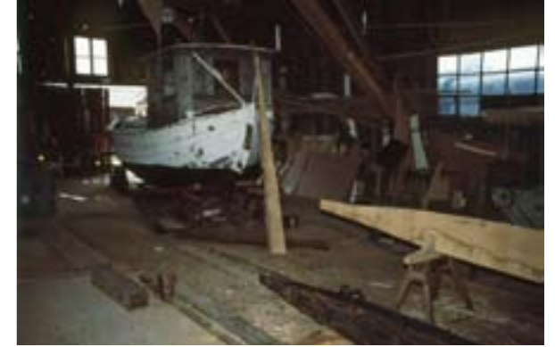
Abb. 10: Wechsel der Bodenplanke (Sohle) des Strandbootes KOS-4 von Koserow/Usedom auf der Bootswerft von Manfred Holtz. Im Vordergrund die alte und die neue Bodenplanke sowie die unterzusetzende Stahlschiene (Kröslin, 2004).
