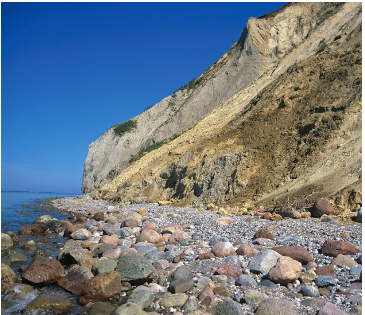
Abb. 4: Nach der Aufarbeitung abgestürzter oder abgerutschter Lockermassen bleibt ein Geröllstrand mit Geschiebeblöcken zurück. Dornbuschkliiff auf Hiddensee (Juni, 2007).
