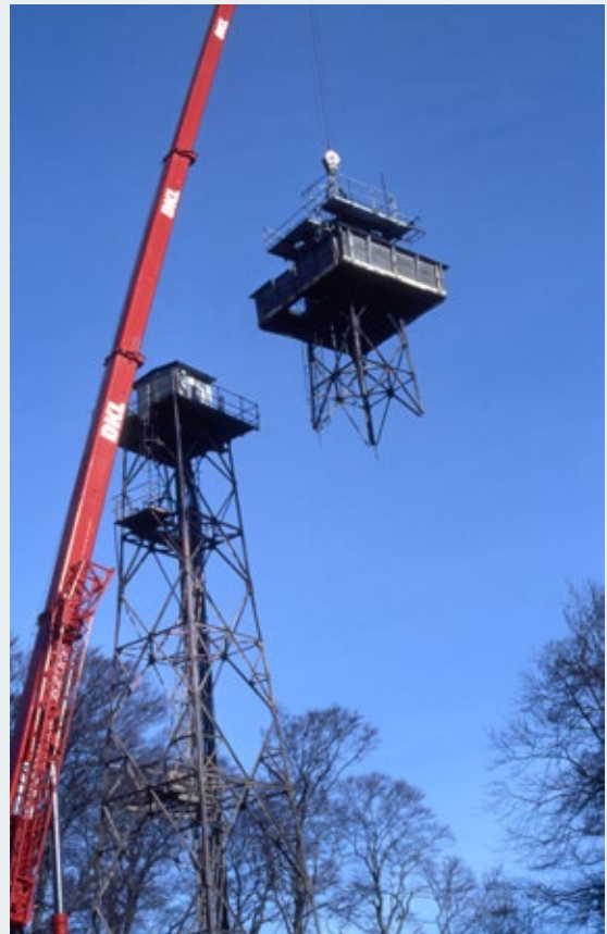
Abb. 6: Der Abriss des Gittermastes zur Grenzbeobachtung 1997 war ein Meilenstein auf dem Weg zur Entstehung des Nationalpark-Zentrums.
