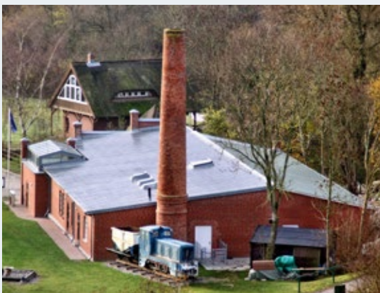
Abb. 12: Blick vom Kleinen Königsstuhl auf die restaurierte und jüngst erweiterte historische Werkhalle des alten Kreidewerks Gummanz im November 2014.
