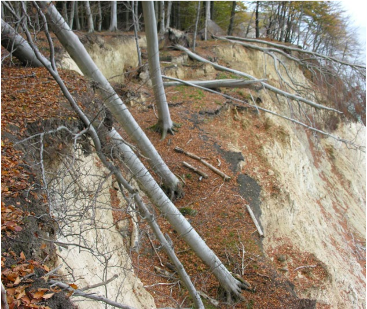
Abb. 32: Ein streifenförmiger Uferabbruch am Hohen Ufer südlich der Mündung des Kieler Baches (2008).
