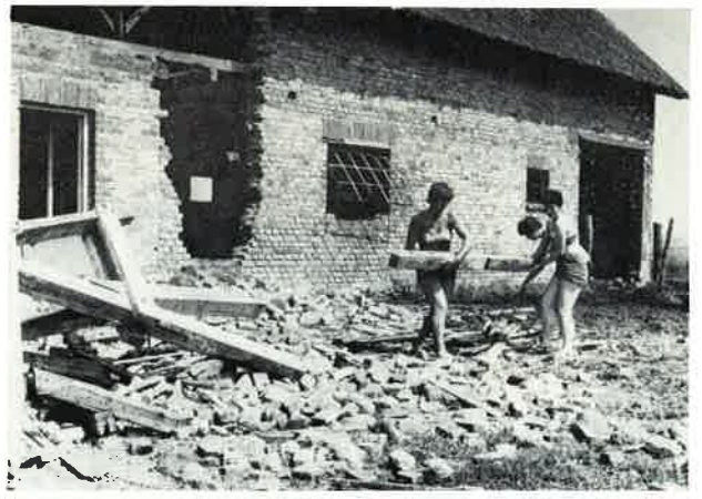
Die Ruine des kombinierten Wohn-Stall-Gebäudes auf der Oie 1963. In dem Jahr wurde der Stallbereich abgetragen und der ehemalige Wohnkomplex zur Außenstation des Meeresmuseums umgebaut.
