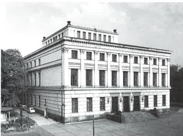
Das alte Gebäude des Zoologischen Museums in Halle.
